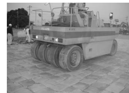
図-13 タイヤローラーで転圧中の角土のうの最上面
