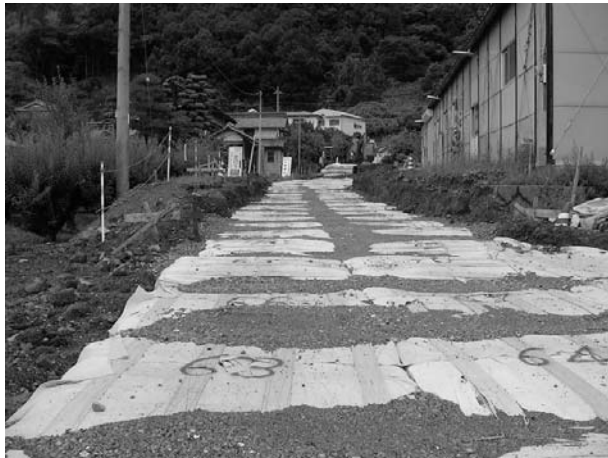
図-18 D・BOX工法 (LS150) の施工状況
