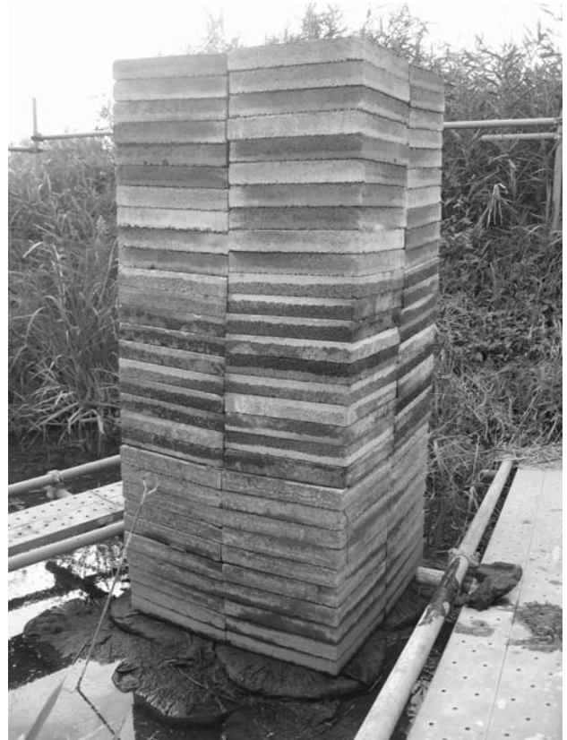
図-4 沼地(深さ約2mのヘドロ層)載荷試験でのD・BOX上のコンクリート平板の積層状態(80cm×80cm×高さ約1.9m)
