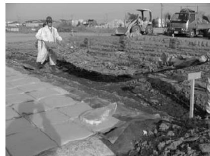
図-11 D・BOX-SS45の作業状況
