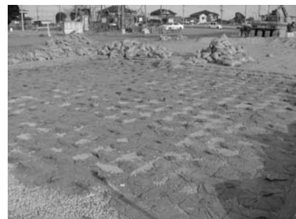
図-12 D・BOX-SS45の敷設状況
