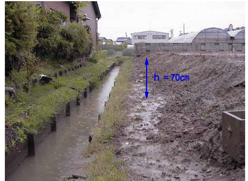
敷地現況 盛土状況と水路
