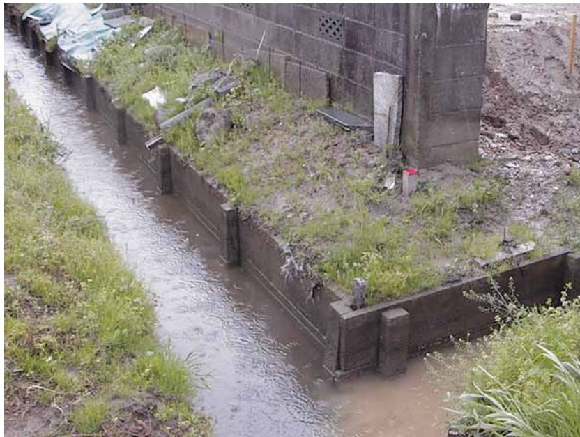
敷地現況 水路
