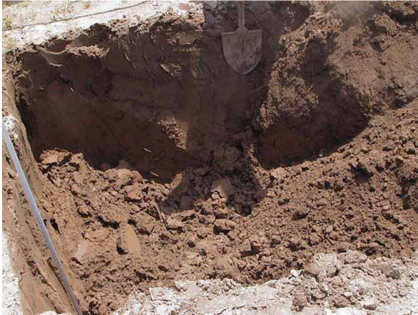
盛土部の地盤 粘土まじりのシルト
