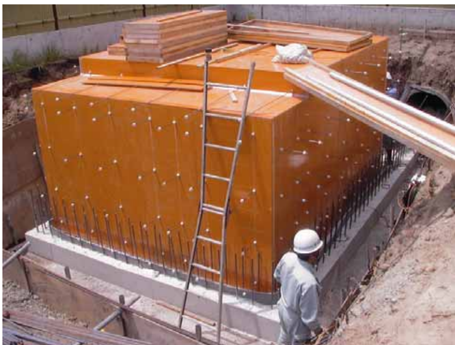
7 2週間程経過した後、躯体工事を行う。 施工中（施工後も）の沈下はまったく起こらなかった。
