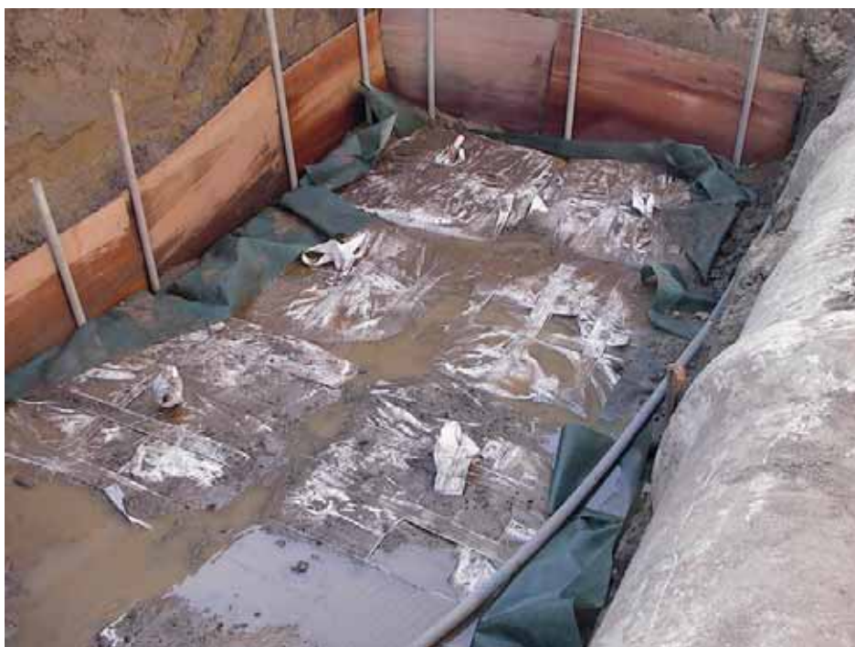
6 D・BOX 敷設完了時の様子（敷設作業は半日で完了）
